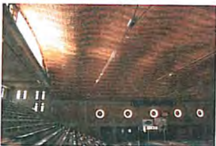
Cubierta del Estadio Bernasconi
